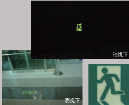
新潟薬科大学 消防指導による設置
